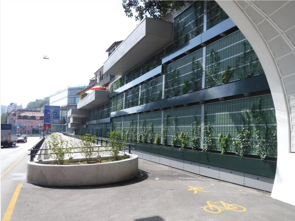
Stützmauer West (ca. 300m 2 )
