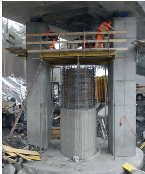
Fig. 11 Pfeilerumbau mit Lagerersatz. Pier reconstruction with replacement bearing.
