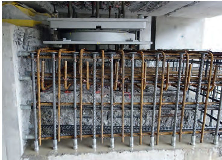
Fig. 9 Widerlagerumbau mit Lagerersatz. Abutment reconstruction with replacement bearing.
