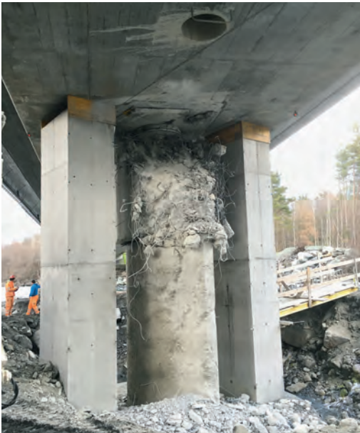
Fig. 10 Abbruch Pfeiler mit beidseitigen Hilfspfeilern. Pier demolition with auxiliary piers on either side.
