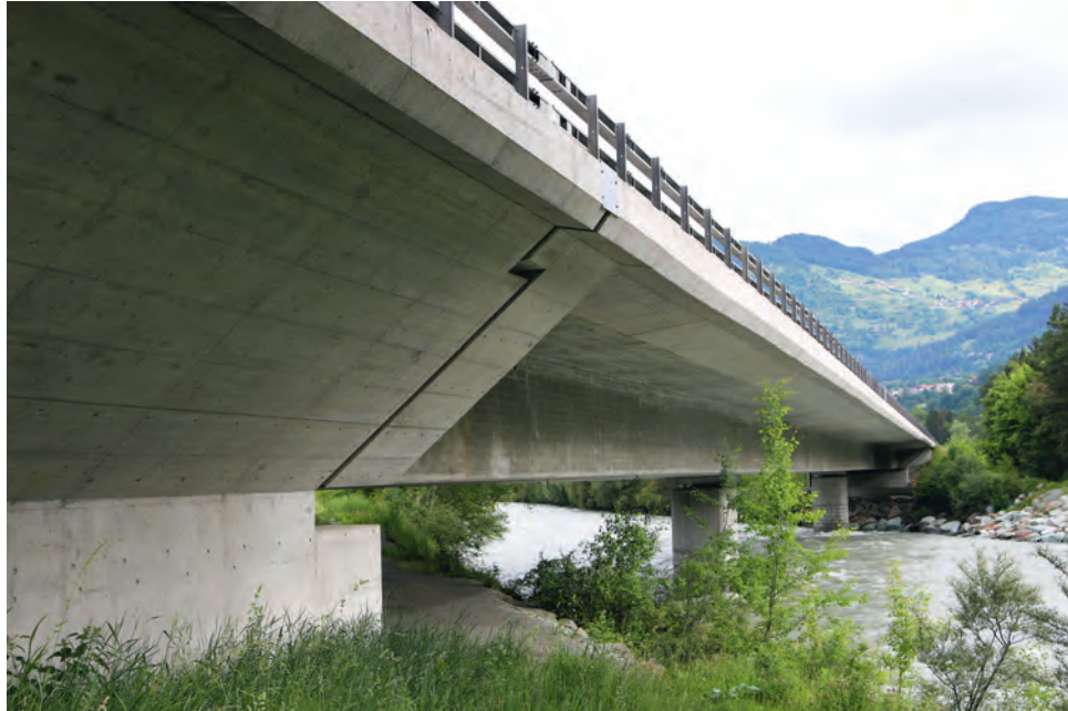
Fig. 1 Instand gesetzte Hinterrheinbrücke Cazis. Rehabilitated Hinterrhein bridge Cazis.
