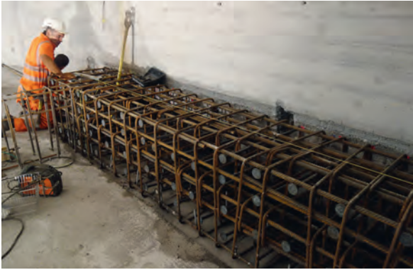
Fig. 7 Bewehrung des Verankerungsblocks der externen Vorspannung. Reinforcement of the anchor block of external prestress.
