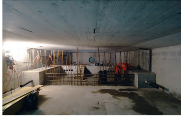
Fig. 8 Betonierte Verankerungsblöcke der externen Vorspannung. Concreted anchor blocks of external prestress.
