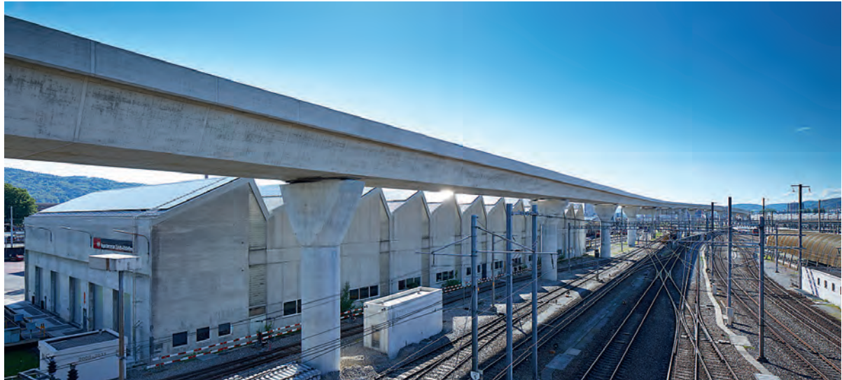
Fig. 1 Letzigrabenbrücke über dem Gleisfeld. Letzigraben bridge over the tracks.
