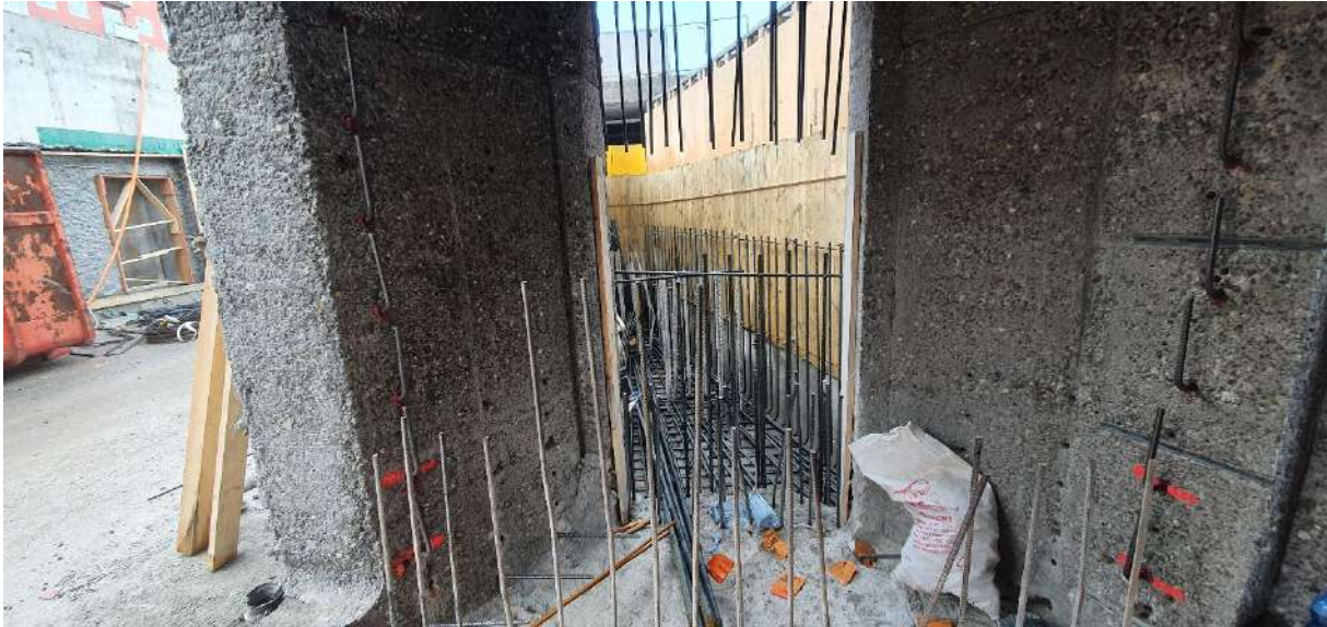
Anpassungen an Zentrale Schöneich, Vorbereitung für Abfangsäule.
