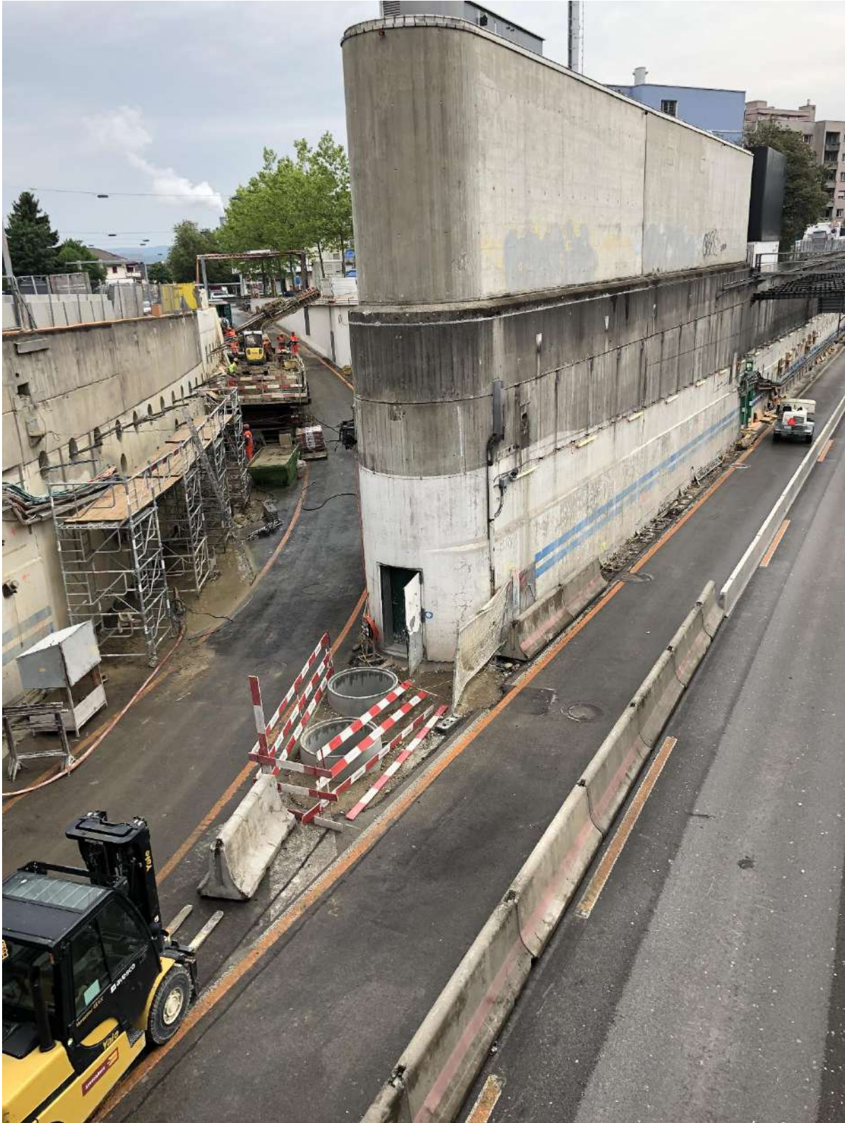
Ankerarbeiten am Ankerfeld K, Vorbereitung Pfahlarbeiten in Einfahrt Waldgarten
