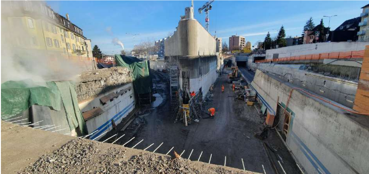
Abbrucharbeiten Ankerwände und Bewehren Stütze in Einfahrt Waldgarten
