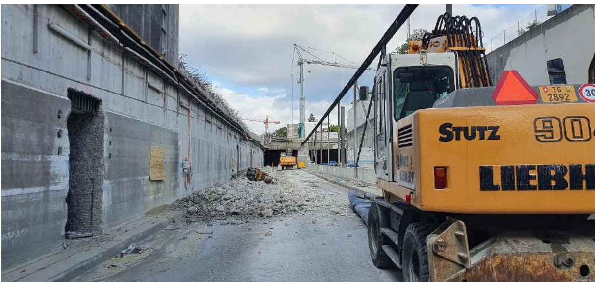
Abbrucharbeiten und Anpassungen an Wänden Waldgarten
