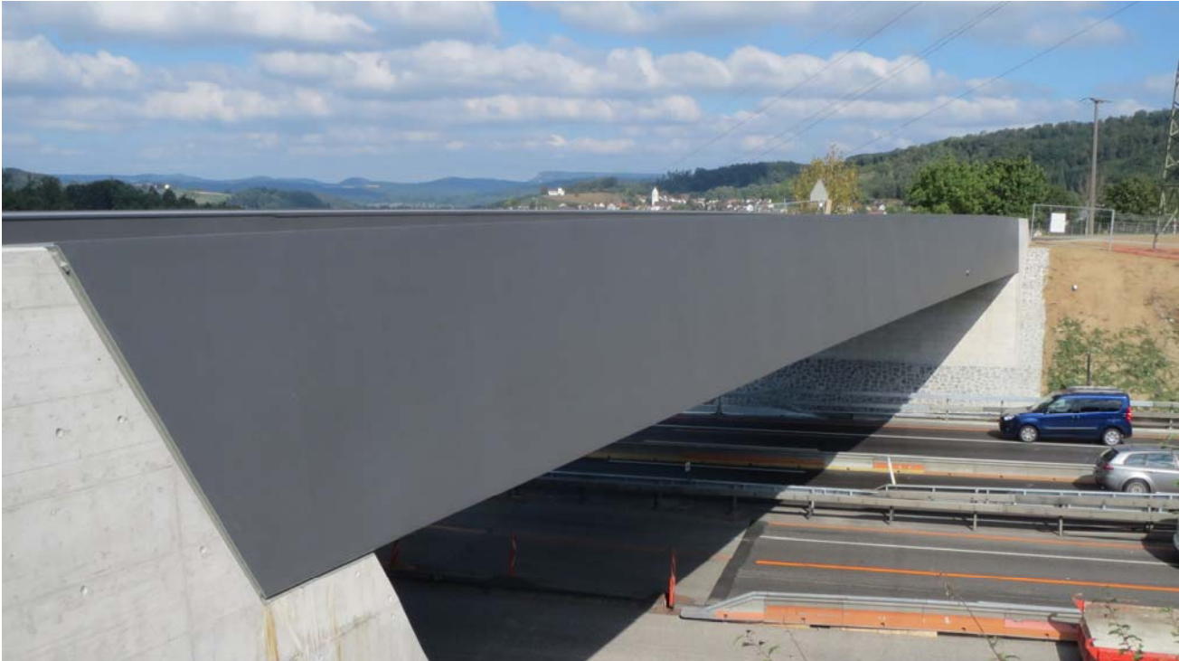
N1-419: Neue Stahl-Beton-Verbundbrücke, Sept. 2015
