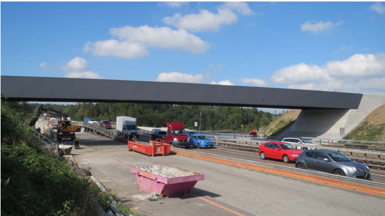
N1-419: Neue Stahl-Beton-Verbundbrücke, Sept. 2015
