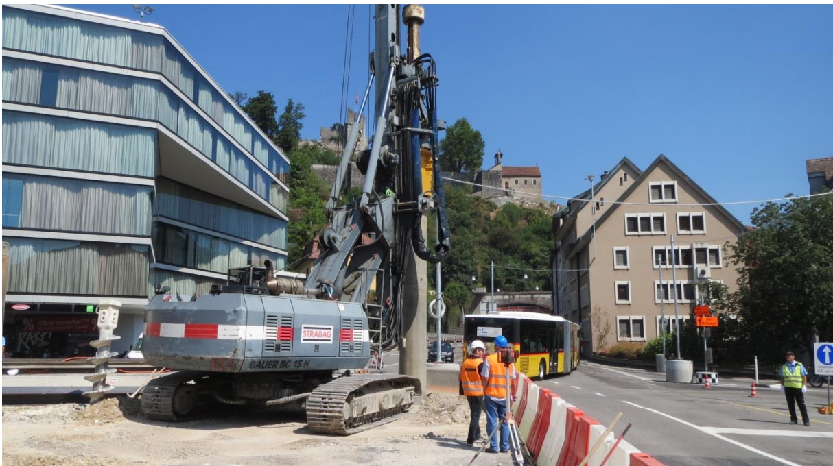
Erstellung von Rühlwänden für 10 m tiefe Baugruben unmittelbar neben dem Verkehr und neben bestehenden Gebäuden
