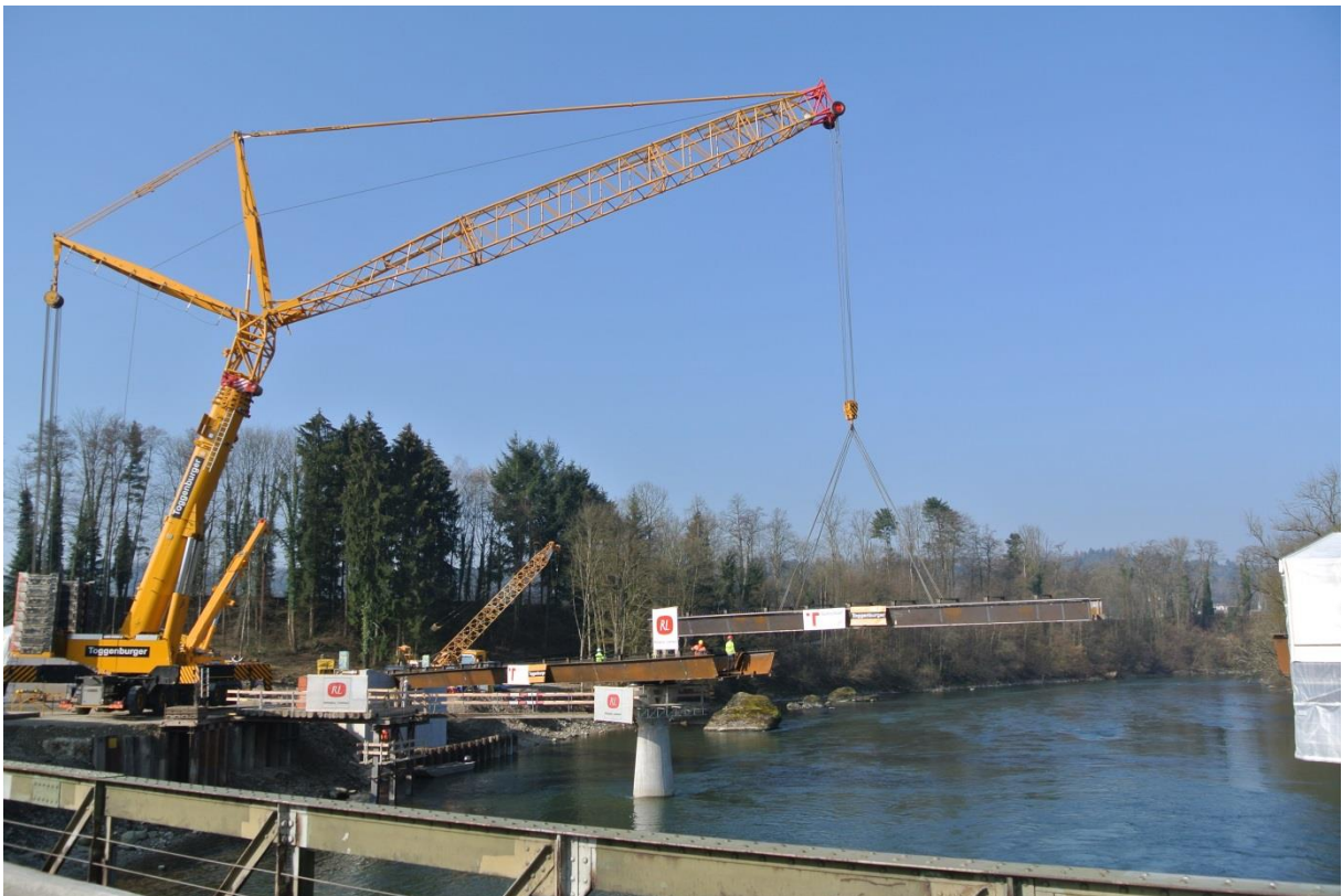
Einheben des Mittelfeldes
