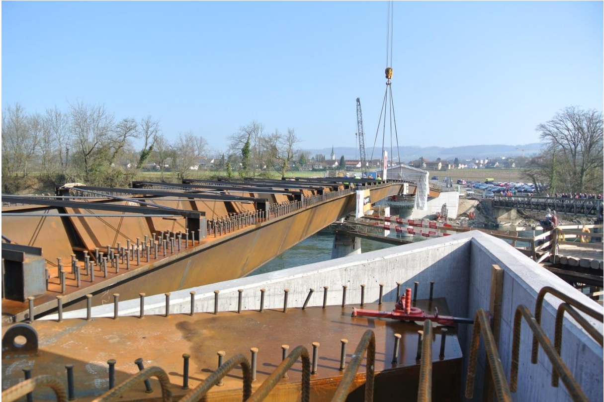
Blick Richtung Norden auf versetzten Brückentrog
